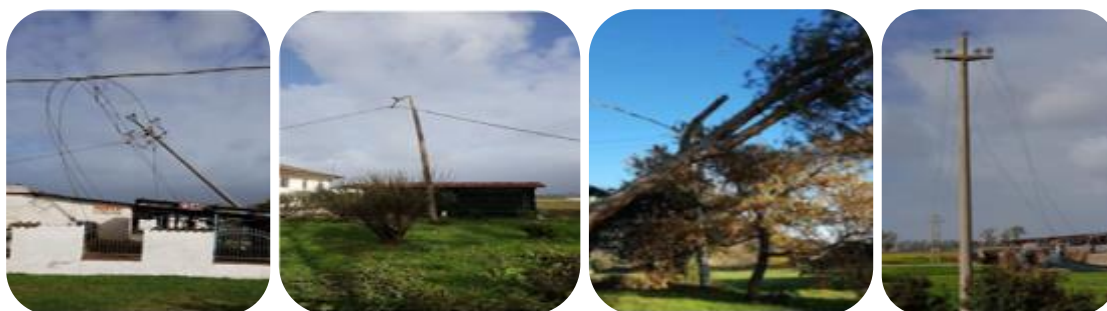
Dicembre 2019. Effetti del vento: caduta sostegni, rottura conduttori delle linee aeree e caduta piante (Lazio)
