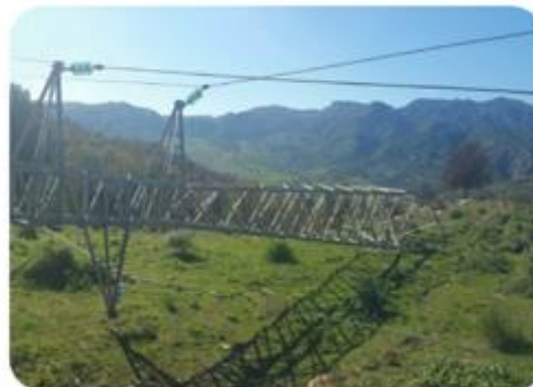
Gennaio 2018. Effetti del vento: caduta tralicci delle linee aeree e caduta piante (Calabria)
