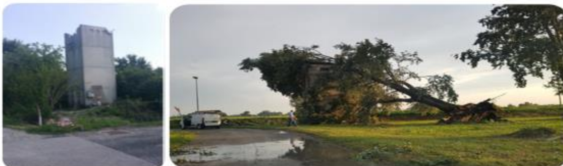
Novembre 2019. Effetti del vento e allagamenti: caduta sostegni, rottura conduttori delle linee aeree e caduta piante (Puglia)
