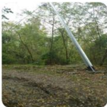
Ottobre/novembre 2018. Effetti del vento: caduta sostegni, rottura conduttori delle linee aeree, difficoltà logistiche (Toscana e Umbria)
