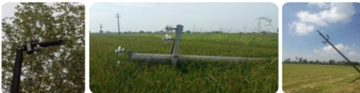
Agosto 2019. Effetti del vento: caduta sostegni, rottura conduttori delle linee aeree e caduta piante (Veneto)
