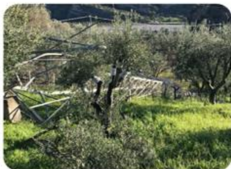
Gennaio 2018. Effetti del vento: caduta tralicci delle linee aeree e caduta piante (Calabria)
