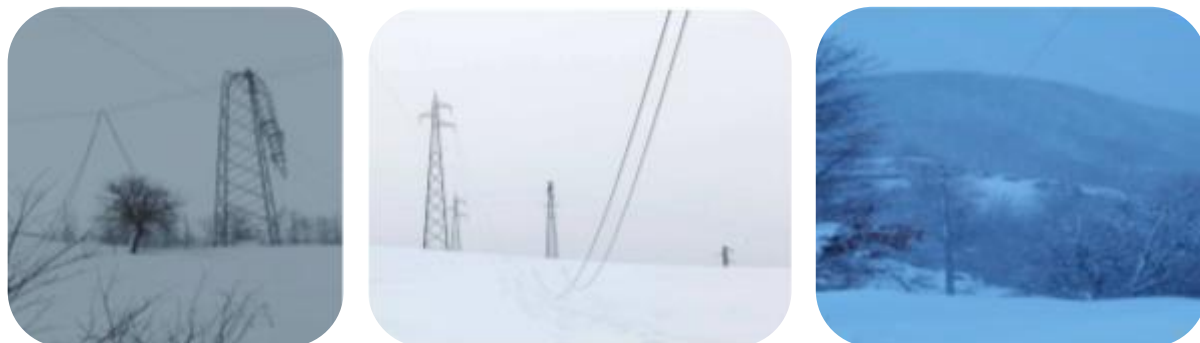
Gennaio 2019. Effetti delle nevicate: caduta sostegni, rottura conduttori delle linee aeree e caduta piante (Basilicata)
