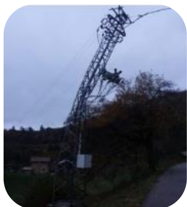
Ottobre/ novembre 2018. Effetti del vento: caduta tralicci, rottura conduttori delle linee aeree, difficoltà logistiche (Veneto – Friuli-Venezia Giulia)
