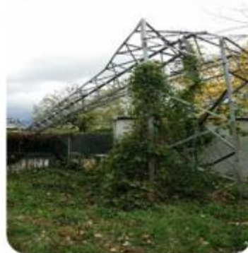
Ottobre/novembre 2018. Effetti del vento: caduta sostegni, rottura conduttori delle linee aeree, difficoltà logistiche (Toscana e Umbria)
